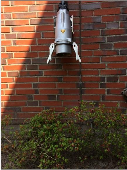
**Abbildung 26 Außengestaltung des Anschlusses Notstromversorgung**
