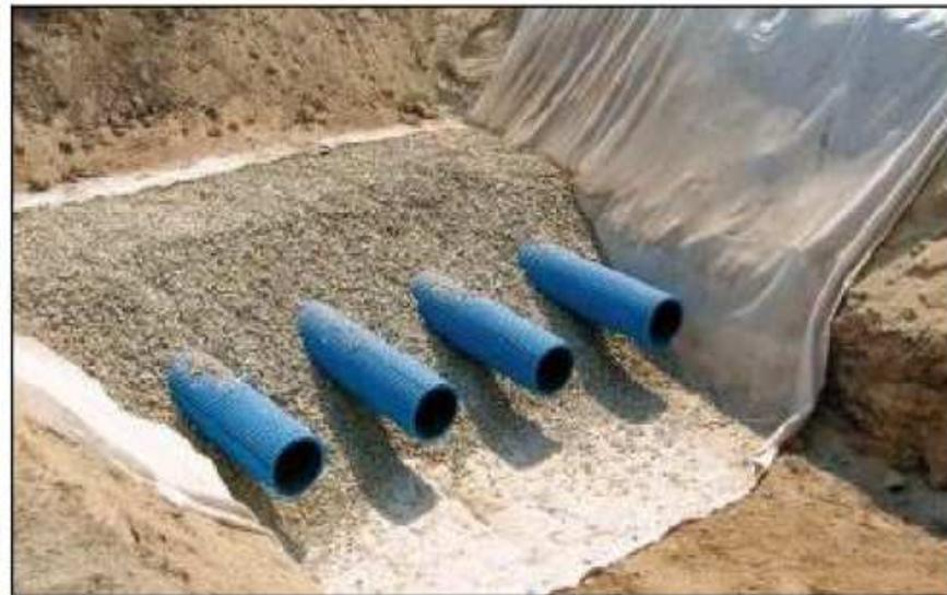
Rohr-Rigolenversickerung [Bildquelle: BSU, 2006]
